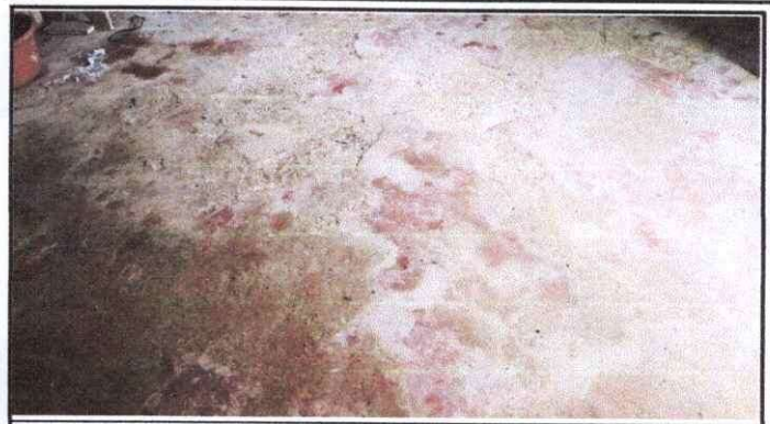
Foto 2: SUSTITUCION DE PISO CERAMICO AULAS
