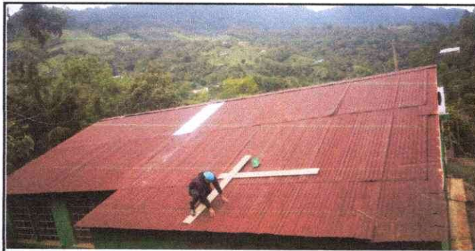
Foto 5: SUSTITUCION DE LAMINA POR LAMINA TROQUELADA ALUCINC CALIBRE 26 CON TORNILLOS PULSER.
