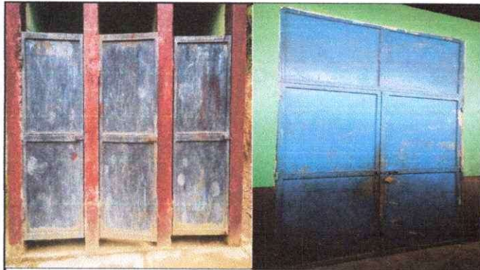
Foto 3: MANTENIMIENTO A ESTRUCTURA DE PUERTAS.
