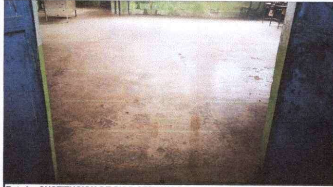
Foto1: SUSTITUCION DE PISO CERAMICO.
