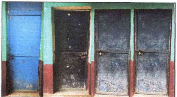
Foto 4: MANTENIMIENTO A ESTRUCTURA DE PUERTAS.
