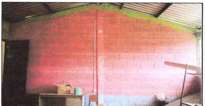
Foto 6: REPELLO EN MURO
